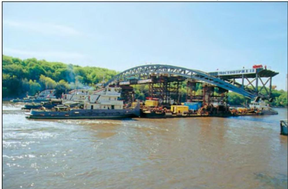
*Схема расположения барж при транспортировке пролетного строения Андреевского моста.*
