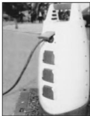
фото), в которой находится вторичная обмотка, а снаружи смонтированы четыре защищенные розетки с обычным сетевым напряжением. Через асфальт можно получать до четырех киловатт мощности.
