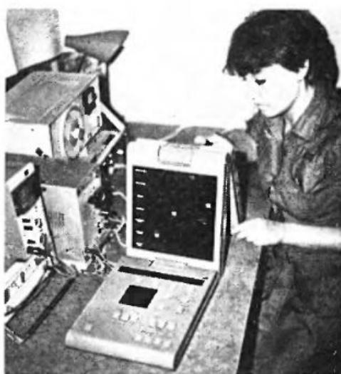
Настраивается приемник для цифрового радиовещания, один из советских экспонатов на международной выставке в Женеве. Внизу — лазерное звукозаписывающее устройство, с его помощью готовятся диски-оригиналы для лазерных проигрывателей.
