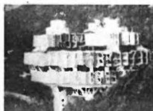
В железобетонных опорах разместятся инженерные коммуникации: лифт, водоснабжение, электропроводка. Опора на грунт — минимальная, лес внизу почти не тронут, и все здание как бы сливается с рельефом, становится его неотъемлемым элементом.
