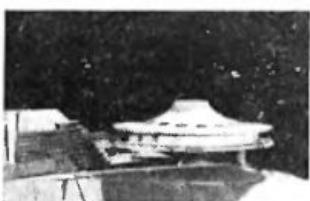
единственны возможны для большепролетных сооружений. В интерьерах этих зданий отсутствуют внутренние опоры: в них нет нужды, так как элементы конструкций «парящих крыши» работают на растяжение и держат сама себя.
