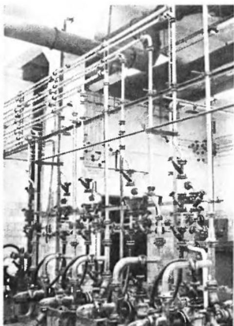
Завод автотранспортной электроаппаратуры. Стеклянные трубопроводы для транспортировки кислот в гальваническом отделении.
