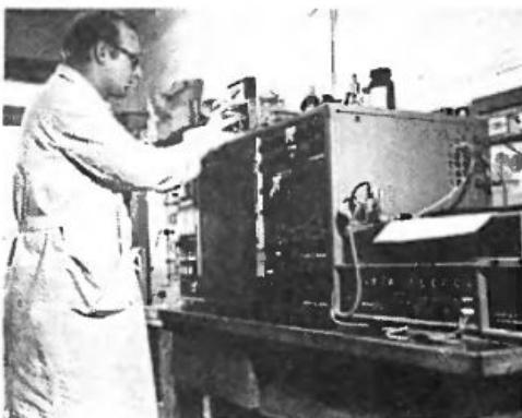
Используя современные хроматографические методы (на снимке вы видите работу с газовым хроматографом), которые позволяют разделять на составные части и анализировать различные смеси, специалисты в состоянии обнаружить в любом лекарстве те или иные примеси и посторонние включения и определить их количество.
