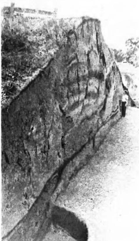
Разрез вала окольного города (первая половина XII века). Высота вала 6—8 метров. Основанка земляной насыпи составляет три ряда деревянных срубов, забитых глиной и сверху обожженных. По вершине проходила деревянная стена.
