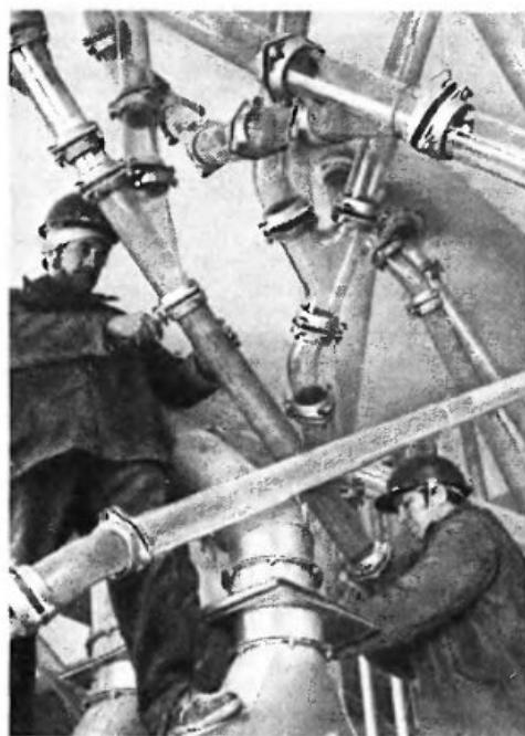
диаметром до 200 мм. При диаметре до 50 мм — методом горизонтального вытягивания, при большем диаметре — вертикальным вытягиванием. Чем больше диаметр трубы, тем толще ее стенки: при диаметре 50 мм толщина стенки 5 мм; при диаметре 200 — 11,5 мм.
