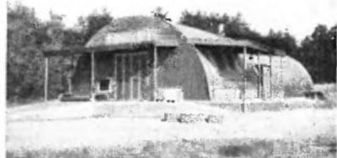
Фирма Наккнлан Конепая выпускает сборные амбары, овощехранилища и другие производственные помещения, используя в качестве «стенового материала» тонкий гофрированный стальной лист, защищенный от непогоды антикоррозионными покрытиями. Строения комплектуются системами теплоснабжения, освещения, вентиляции. Типичное овощехранилище имеет площадь около 500 квадратных метров ( $15 \times 36$  м), самое большое — 2400 ( $24 \times 100$  м).
