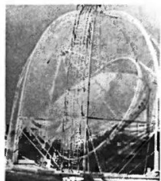
Сейчас построено две таких установки с зеркалами диаметром 3 и 10 метров. Они дают соответственно 1 и 10 киловатт энергии. А масса, приходящаяся на один киловатт мощности, — менее 500 килограммов, что уже приближается к удельной мощности традиционных тепловых электростанций.
