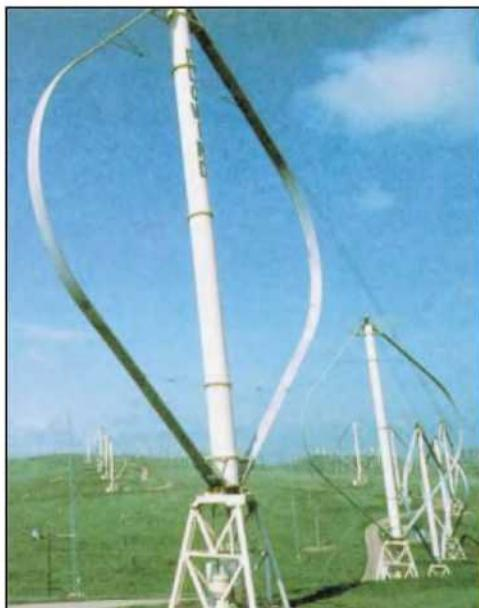
Роторные ВЭС могут иметь лопасти разной формы и конфигурации (см. также фото на стр. 11).
