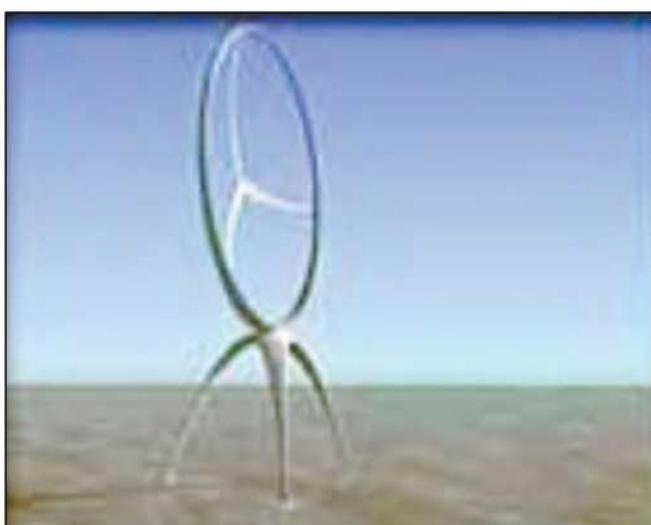
ВЭС новой конструкции: лопасти вращаются внутри колеса с подшипником, установленного на трехопорном основании.
