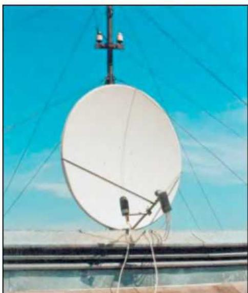
*Фото 4. Приемный блок, объединяющий поляризатор, конвертор и облучатель.*
