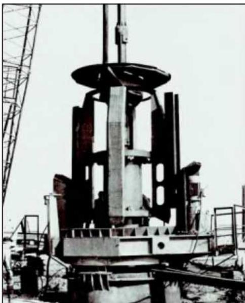
Сегодня подготовку оснований фундаментов проводят иначе — при помощи так называемых буронабивных свай. Это значит, что вместо использования готовой сваи просто бурят скважину глубиной до 50 м и диаметром до 2 м и заполняют ее бетонной смесью. Применяемое для такой цели оборудование у нас в стране серийно не выпускают, а за рубежом производят, но стоит оно весьма дорого и доступно лишь очень богатым строительным организациям.
