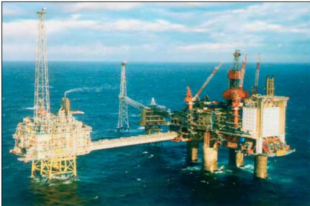
*Отслужившая нефтяная буровая установка используется для закачивания двуокиси углерода в выработки, оставшиеся под дном моря.*
