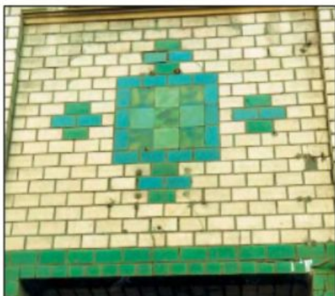
Бутырская улица, дом 73. Композиция из плиток и «кабанчика» над входом в парадный подъезд. 1910-е годы.
