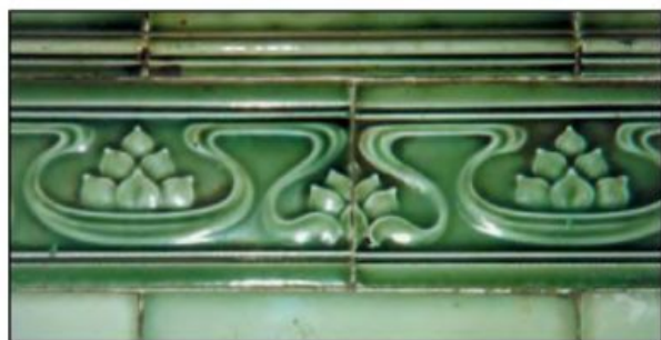
Москва, улица Большая Дмитровка, дом 9. Архитектор А. Э. Эрихсон. Интерьер подъезда, «кабанчик» под названием «Лотос Египта». 1905 год.
