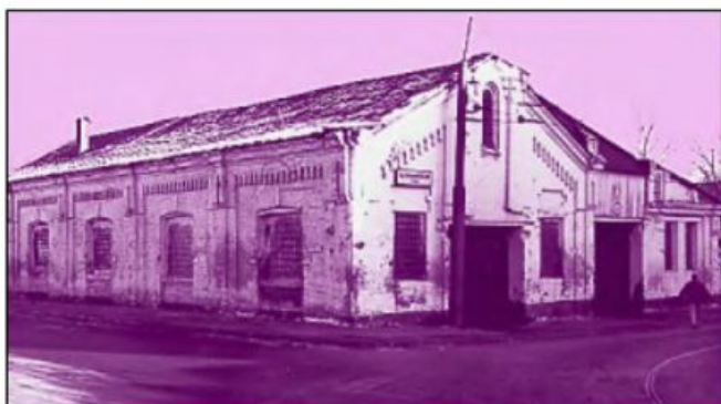
Бауманская ул., 1. Бывшие хлебные лабазы. Вид с северо-запада.
