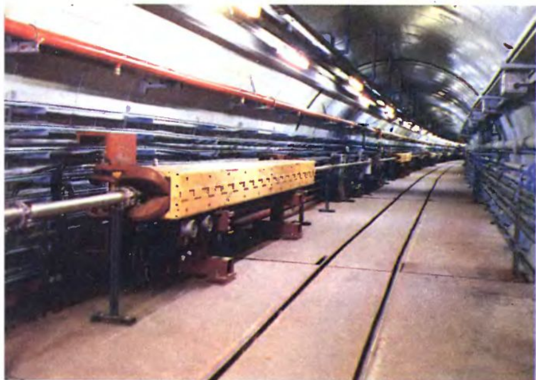
Вверху: готовый тоннель с ускоряющими электромагнитами и вакуумной камерой — трубой, по которой движутся частицы.
