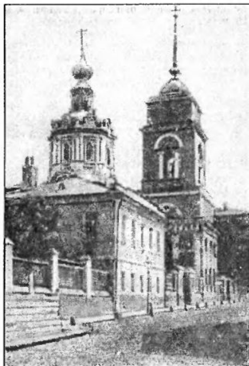
Собор Варсонофьевского монастыря. 1692—1730 гг. Зимой 1931 г. собор был разрушен. На его месте (Варсонофьевский пер., д. 5) в начале 30-х гг. было построено современное здание.
