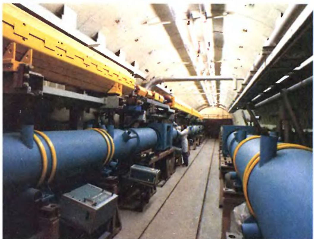
Вверху: готовый тоннель с ускоряющими электромагнитами и вакуумной камерой — трубой, по которой движутся частицы.
