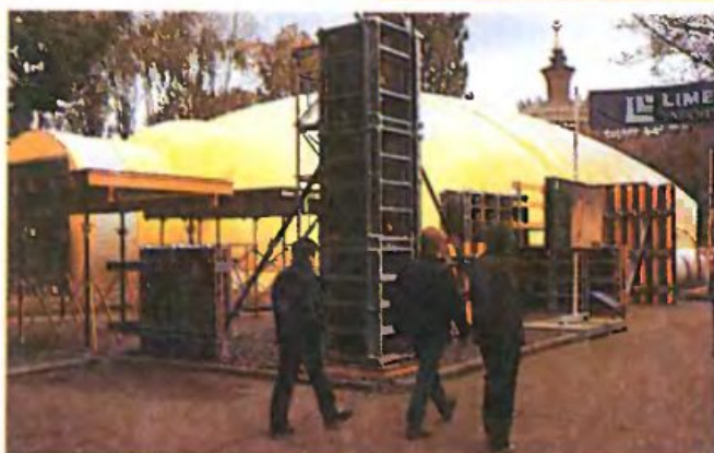
Элементы универсальной опалубки могут комбинироваться различным образом, давая опалубку для отливки бетонных колонн, стен, перекрытий, фундаментов.
