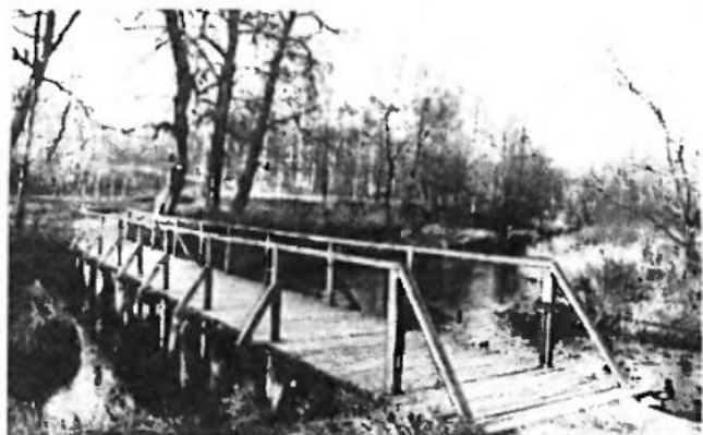
Деревянный мостик над Пономаркой.
