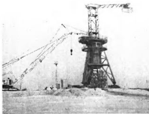
Монтаж башни солнечного парогенератора.
