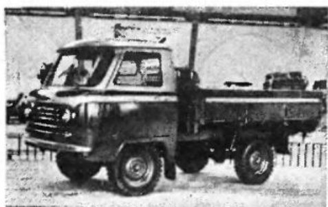
УАЗ-450Д (1958—1965 гг.). Первый советский грузовик с кабиной над двигателем. Машина была унифицирована по важнейшим узлам с джипом ГАЗ-69. Рабочий объем двигателя — 2432 см 3 . Мощность — 62 л. с. (45 кВт). Длина машины — 4,3 м. Масса в снаряженном состоянии — 1,65 т. Грузоподъемность — 0,8 т. Скорость — 90 км/ч.
