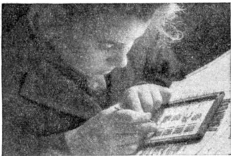
Каким нужно обладать терпением, чтобы правильно собрать кассету запоминающего Устройства — сплести тончайшее кружево из едва различимых глазом ферритовых сердечников!
