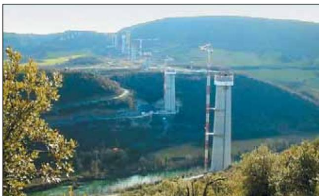
▲ *В марте 2002 года в долине реки Тарн приступили к возведению пилонов виадук Мийо (вверху). Местоположение каждого пилона определялось с помощью средств спутниковой навигации GPS. Благодаря применению скользящей опалубки пилоны «росли» с высокой скоростью, прибавляя в росте по 1,3 м в сутки (внизу).*
