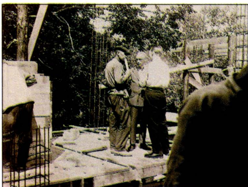
На строительстве дома Наркомфина. В центре — автор проекта М. Я. Гинзбург. Фото начала 1930-х годов.
