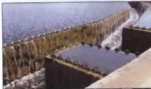
*Из отстойника в лоток попадает вода только из поверхностного слоя. Она стекает через впадины гребёнки, идущий по всему периметру лотка.*
