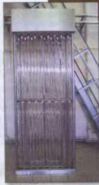
Такие блоки ультрафиолетовых ламп используют для обеззараживания воды.
