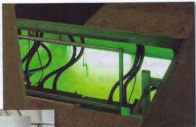
Лампы устанавливают в туннеле, из которого вода сбрасывается в реку.
