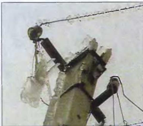
Куски льда на проводах, изоляторах и несущих конструкциях порой достигают значительных размеров и массы.
