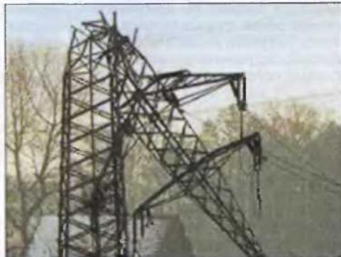
Многотонные слои льда на проводах ломают даже стальные и железобетонные опоры.
