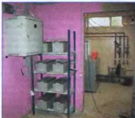
«ВЭУ-2000», смонтированная на участке частного дома (Московская область). Батарея фотоэлементов размещена на крыше подсобного строения, приборы и оборудование — в подвале.
